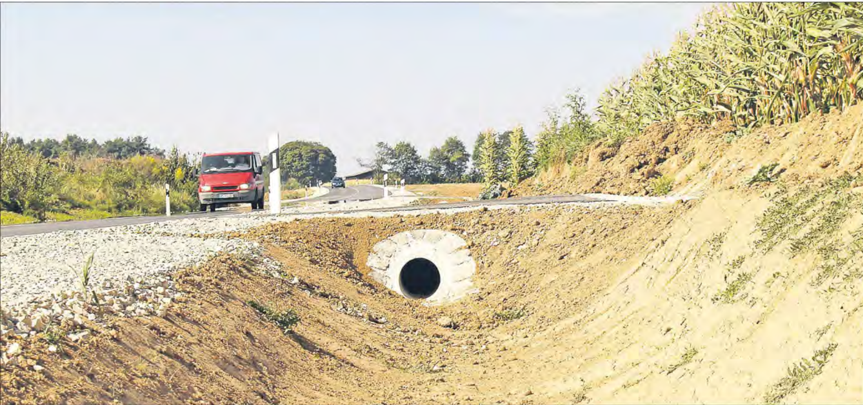
Die Trasse wurde auf 6,50 Meter verbreitert, der Oberflächenkanal in der Straße saniert.
