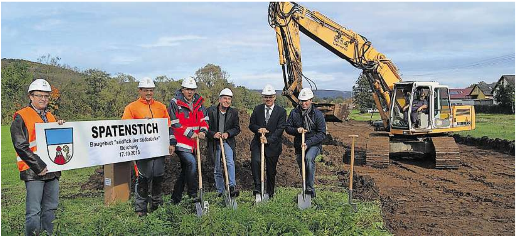
Werner Schneider (v.l.) und Christian Ferstl von Pusch Bau, Dipl.-Ing. Markus Plank vom Bauamt, Bürgermeister Ludwig Eisenreich (2.v.r.) sowie Werner Norgauer und Alexander Csernik von BBI Bauer Beratende Ingenieure freuten sich über den Spatenstich. Foto: Gabler
